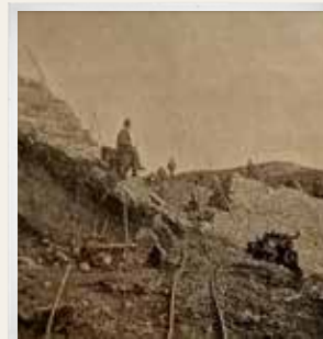
Bau der „Hohen Mauer“
